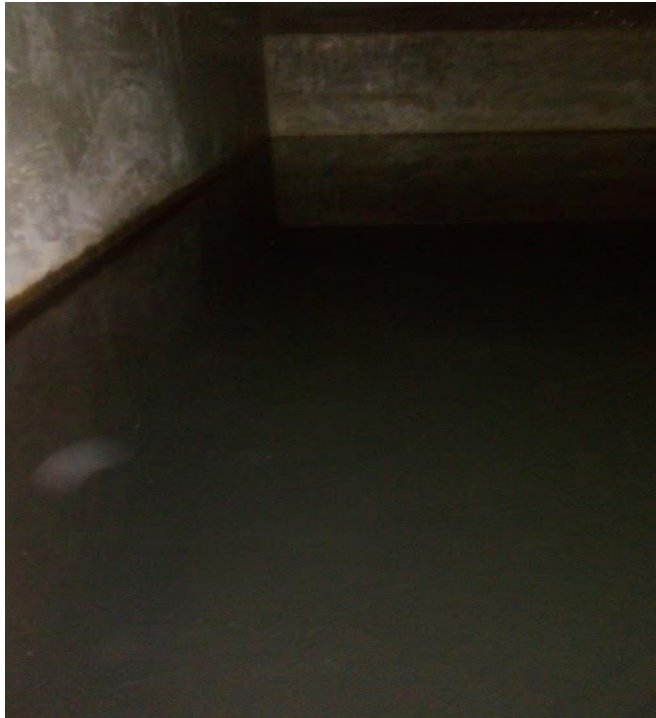
Mantenimiento de cisterna o tanque elevado
