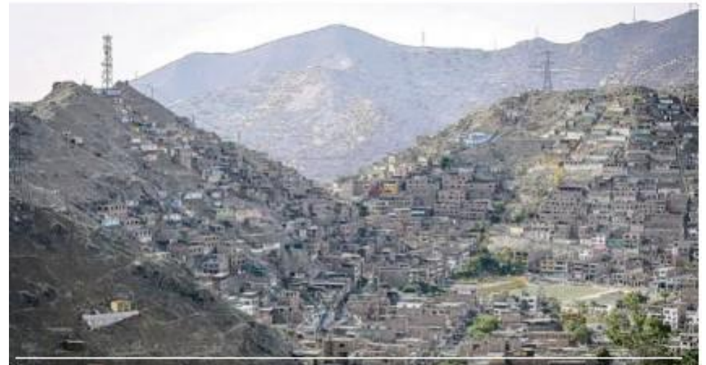
La autoconstrucción es lo que predomina en los barrios populares de Lima. Ello pone en peligro a millones de personas. Un gran sismo podría dejar 120.000 muertos, señalan expertos. Foto: John Reyes/La República
