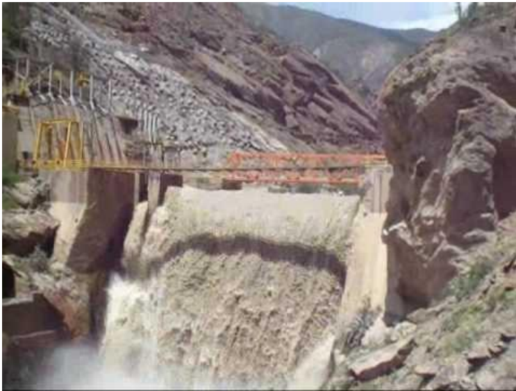
Central Hidroeléctrica del Cañon del Pato
