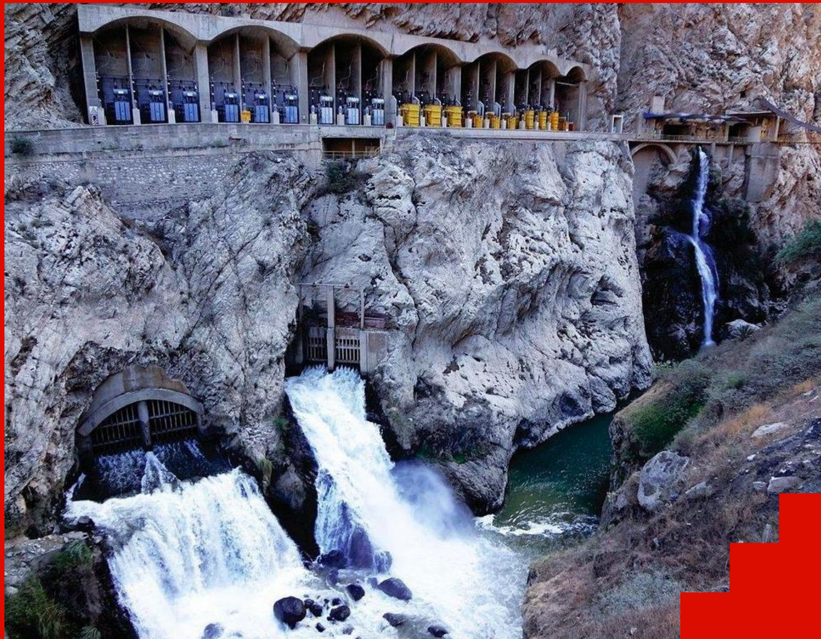
Foto. Central Hidroeléctrica del Cañon del Pato, Ancash
